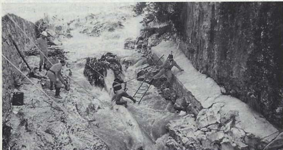
Il pericoloso e faticoso lavoro di pulizia del torrente.
