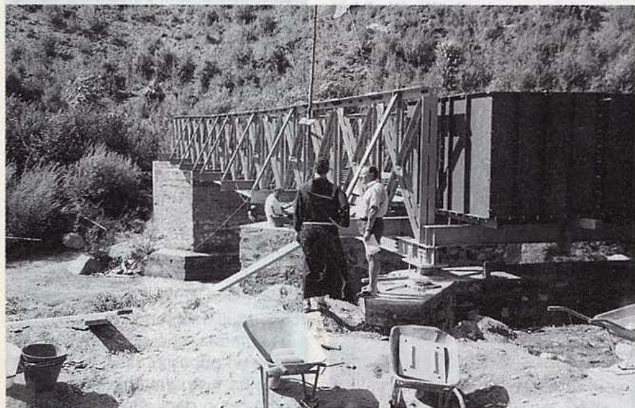
Il "Ponte degli Alpini" sul fiume Kiri in fase di allestimento
