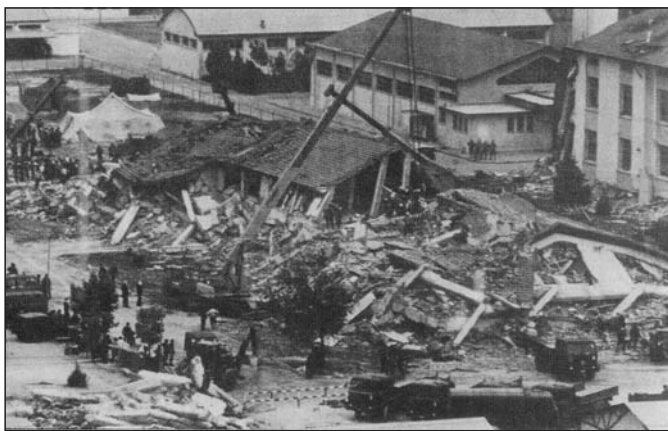
Gemona 6 maggio 1976: l'edificio crollato nella caserma "Goi"
