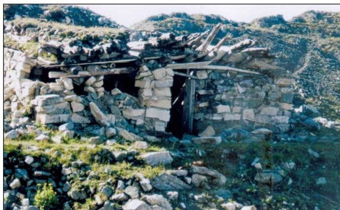
Baraccamenti nei pressi del rifugio
