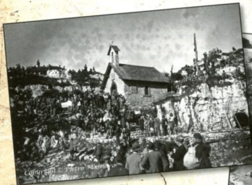
La restaurata chiesetta del Lozze; sulla dx l'apertura della cavità dove sarà ricavato l'Ossario
